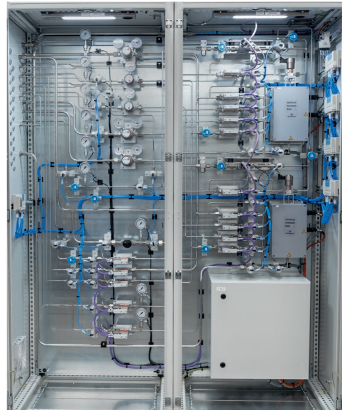
CVD Silan -Chlorgasverteilung – orbital verschweißt
